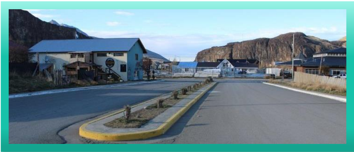
Fig. 10: Fotografía actual del Bloque 1 del bulevar de la Av. Antonio Rojo.
