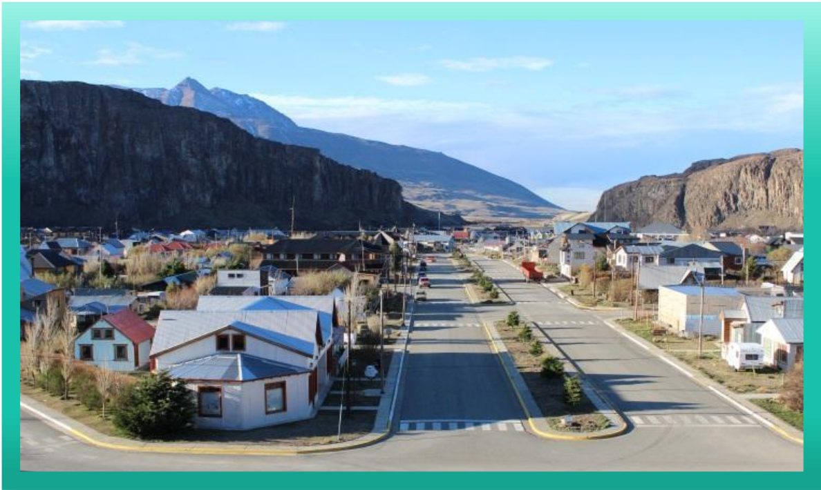
Fig. 11: Fotografía actual de los Bloques 2, 3, 4 y 5 del bulevar de la Av. Antonio Rojo.
