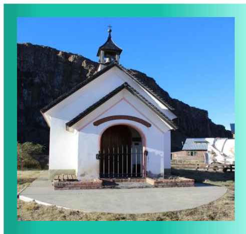
Fig. 17: Fotografía actual del EV Capilla de los Escaladores.
