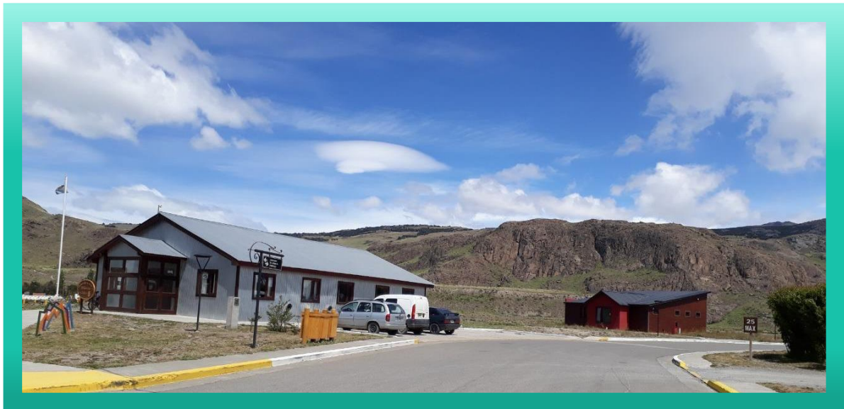
Fig. 27: Fotografía actual del EV HCDEC.
